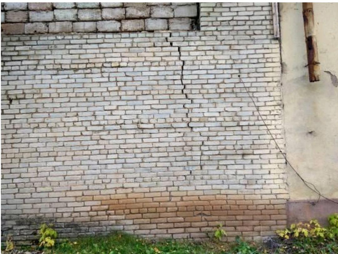
Рис.2. Трещина (ширина раскрытия 12 мм), замачивание цокольной части стены.
