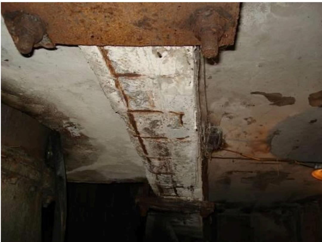
Рис.3. Сколы бетона, коррозия арматуры, разрушение защитного слоя балки.
