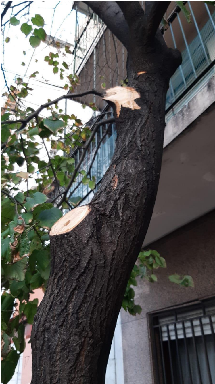
Calle Moreno 2562. Mutilación que afecta su estructura.
