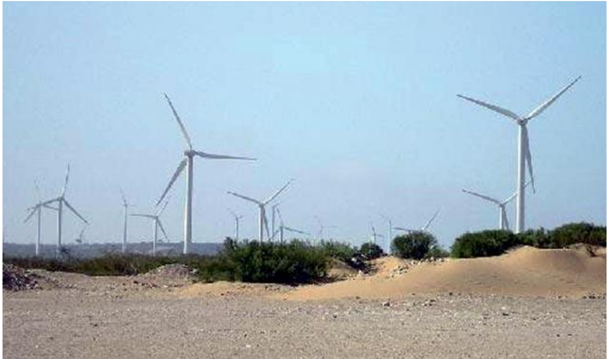
Figure 8 : le parc éolien de Tarfaya [12] .
