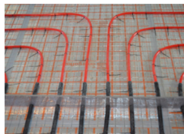
Прокладка трубопроводов в профиле деформационного шва
