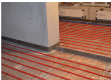
Раскладка контуров теплого пола
