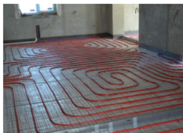
Раскладка контуров теплого пола
