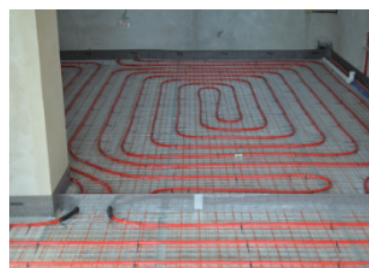
Раскладка контуров теплого пола
