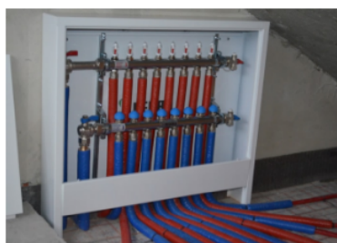
Присоединение трубопроводов к коллектору
