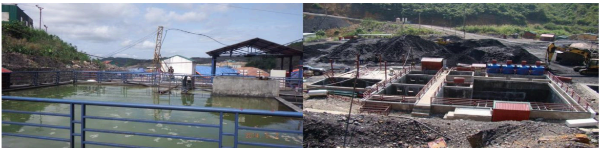
Trạm XLNT Công ty 790 - Trạm XLNT hầm lò Mỏ than Đông Bắc đang thi công
