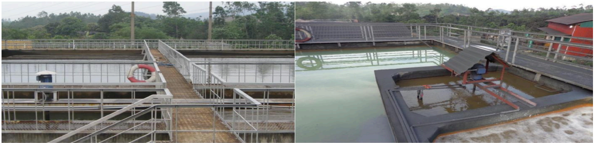
Trạm XLNT hầm lò -80 mỏ than Mạo Khê Trạm XLNT mỏ than Hồng Thái
