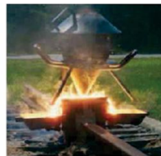
Hình 13.1. Phản ứng nhiệt nhôm để hàn đường ray
