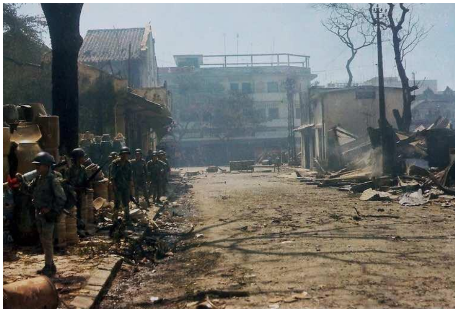
Đoạn đường đầu bến Nguyễn Văn Thành.
