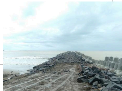
Pembangunan Breakwater sebelah timur dan Pemasangan tetrapod dan Sollar cell di Pelabuhan Perikanan Cikeusik
