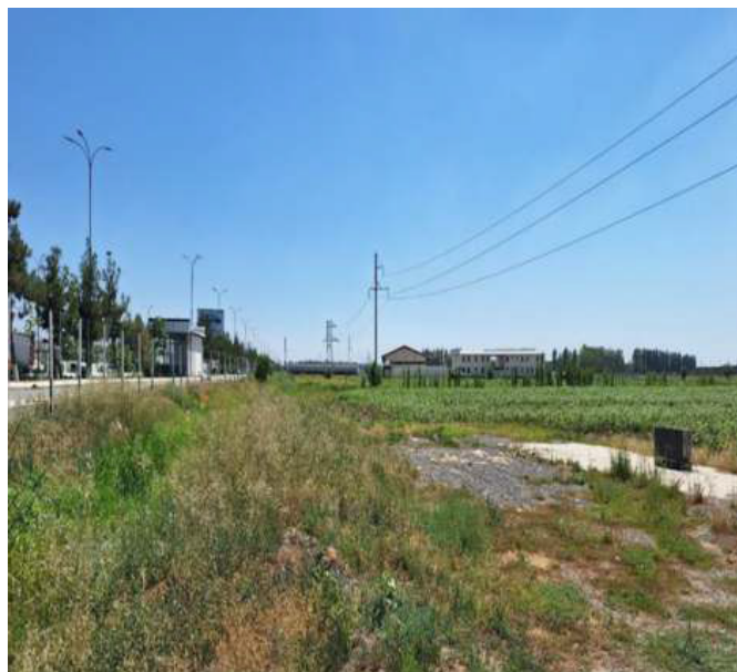
Фото 2. 17.10.2024 Андижан Строительная площадка
