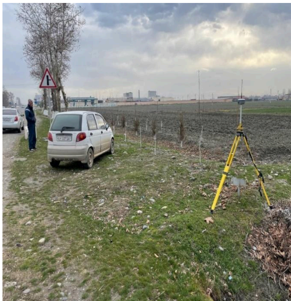
Фото 1. 10.10.2024 г. Самарканд Строительная площадка.
