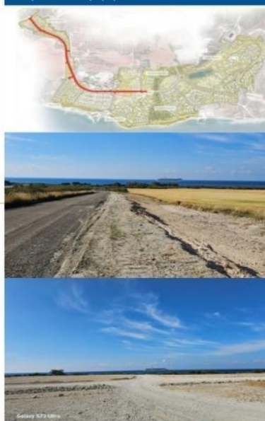
Φάση: Κατασκευή Δρόμου
