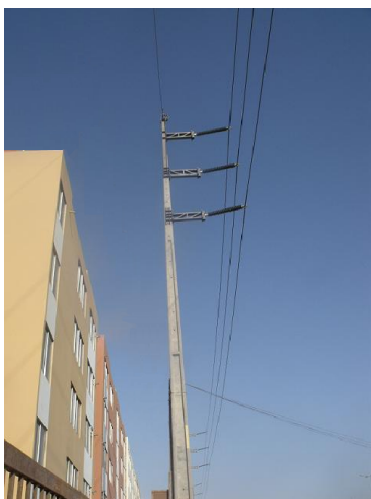
Figura 1. Línea de transmisión trifásica de 13,2 (KV) cuyo tendido está muy cerca de edificios de departamentos en una zona suburbana de Chile mostrando que el campo magnético en el interior de esos pisos es del orden de 50-100 microteslas, que al interactuar con la microonda del celular, en [1] se obtiene un valor del SAR del orden de un 150-300% mayor al valor estipulado por el fabricante si no se blindó con metamateriales. El metamaterial atenúa la radiación compensando el aumento del efecto magnético externo o de la corriente de la batería.
