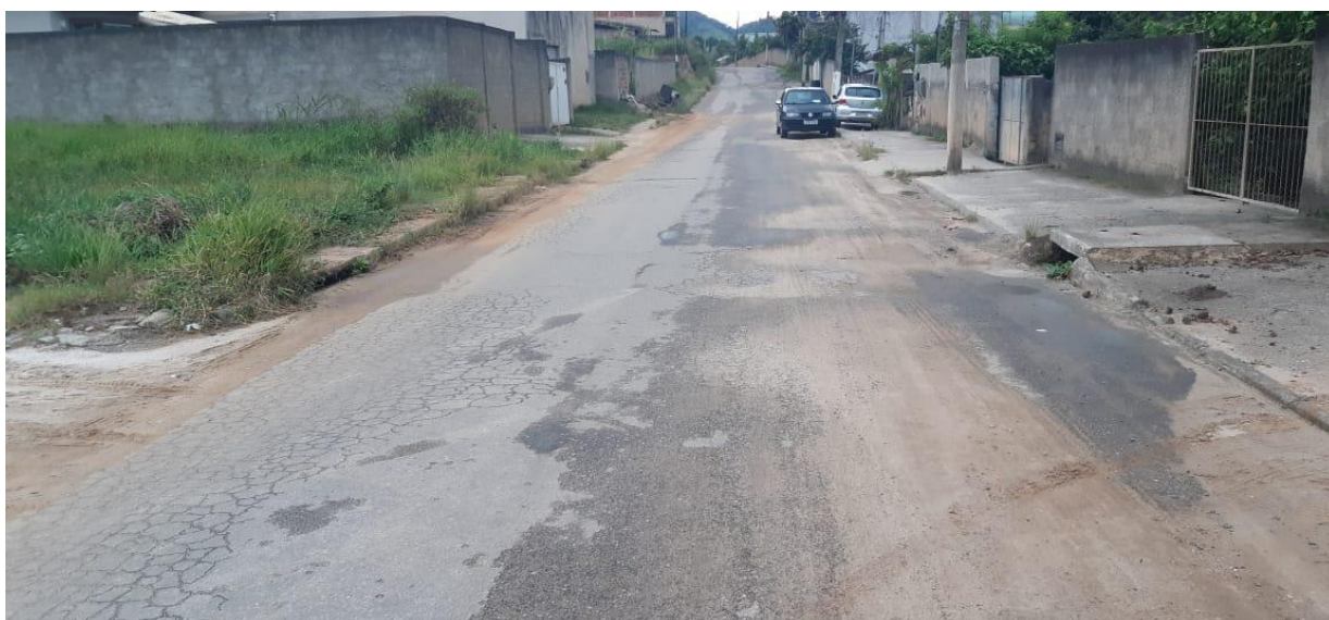
ESTRADA OSWALDO LEMOS – BAIRRO CAJUEIRO
