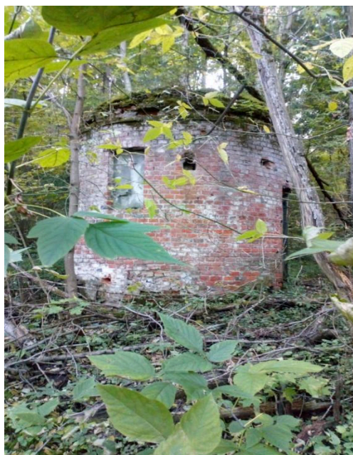
Рис.3. Водонапорная станция (начало 20 века)
