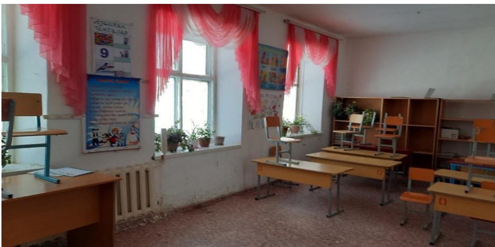
Фото 5. Отсутствует система вентиляции в классах
