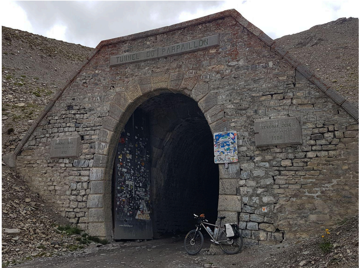
9. Tunnel du Parpaillon
