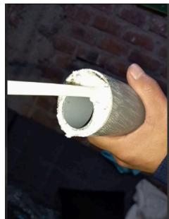
\*Pegar con espuma expansible el tubo de 2 pulgadas con el de 3 pulgadas.
