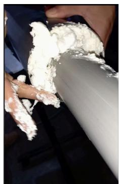
\*Pegar con espuma expansible el tubo de 2 pulgadas con la boca del garrafón.
