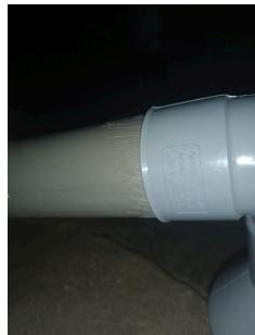
\*Pegar con espuma expansible el tubo de 1 pulgada con el de 2 pulgadas.
