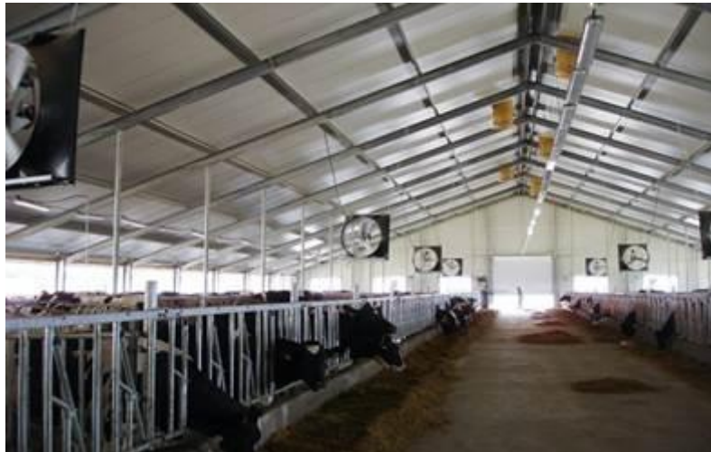
Рис. 2.4.15. Комбінована вентиляція приміщень
