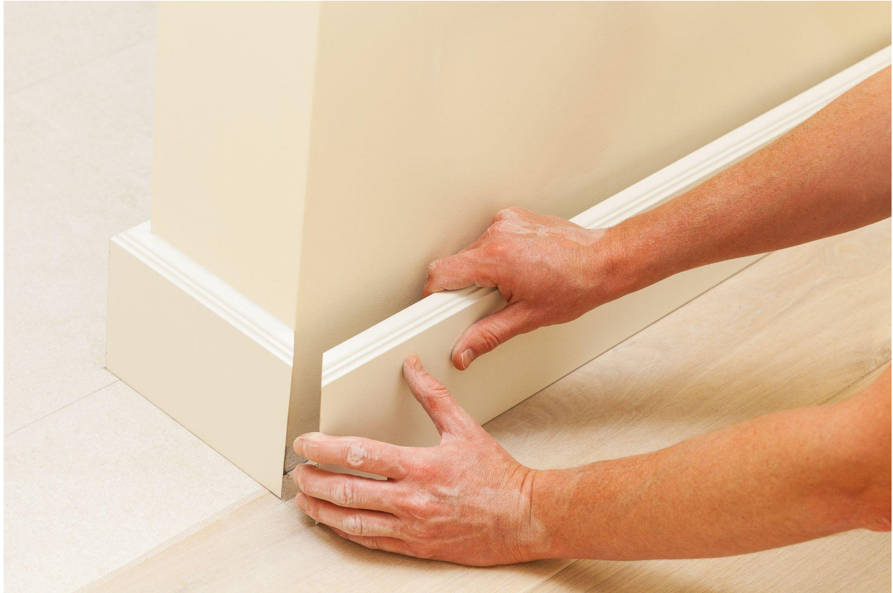
ภาพ: การซ่อมแซมบัวพื้น
