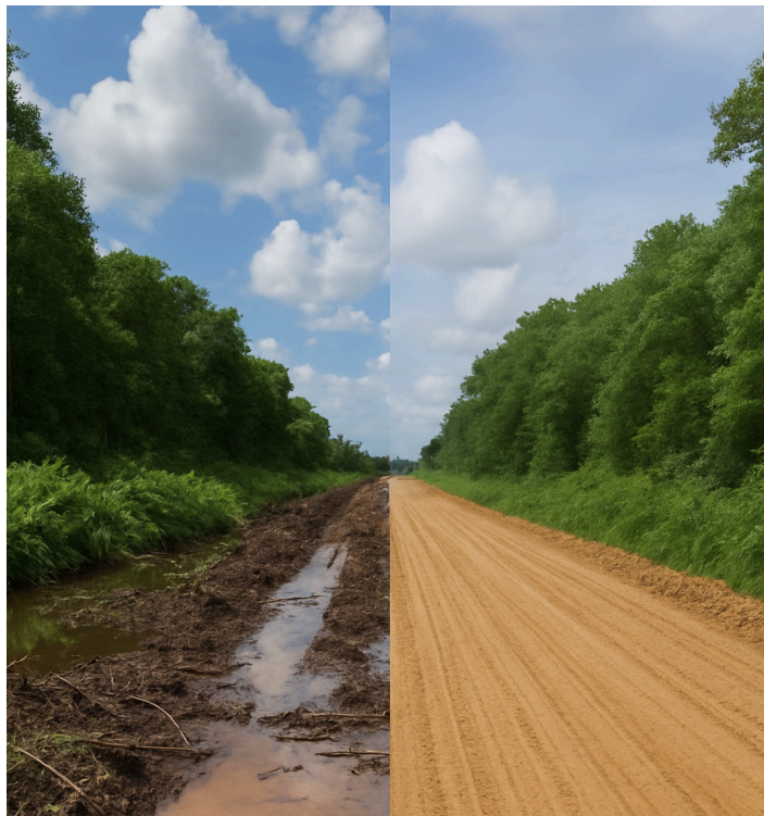
Gambar 3. Kondisi Jalan Akses sebelum dan setelah distabilisasi menggunakan Geogrid
