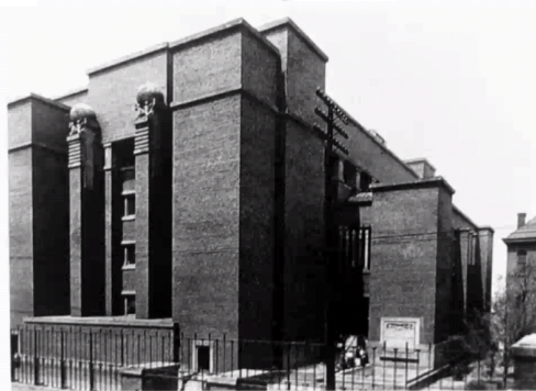
Uffici Larkin Company, 1904-1906, Buffalo Tecnologia e Architettura
