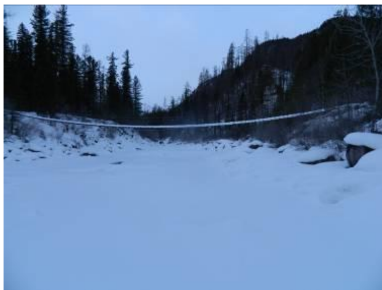
Фото 19 мост через р. Билюты в месте её впадения в р.Китой.
