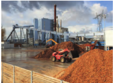
Sumber: www.goodnewsfinlad.com Gambar 5.35 Pembangkit Listrik Tenaga Biomassa Mesto
