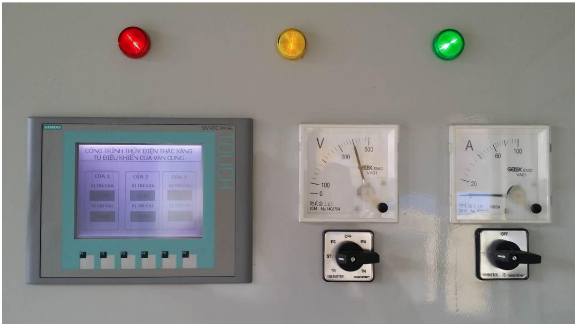
Hình 2.7 Đồng hồ hiển thị của tủ điều khiển tại NMTĐTX
