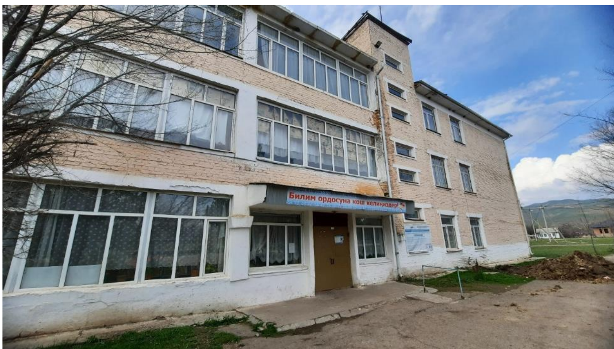
Фото 5 – Вид на учебный корпус
