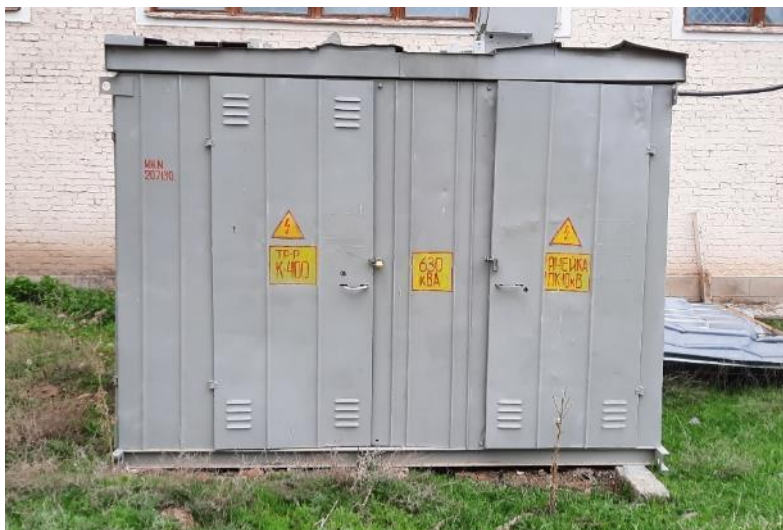
Фото 16. Трансформаторная подстанция 100/10/0,4.
