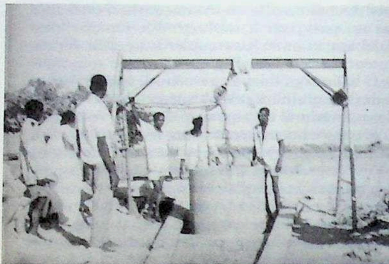
CONSTRUCTION D'UN PUIIS (1977) Gilbert Klopfenstein a consacré du temps à ce ministère de sociale aux Tchadiens.
