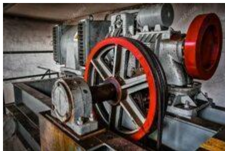
Рисунок 7 – Электропривод лифта
