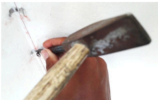
ภาพ ถอดสายกระดิ่งไฟฟ้า
