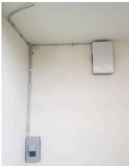
ภาพ แสดงผลงานติดตั้งกระดิ่งไฟฟ้า
