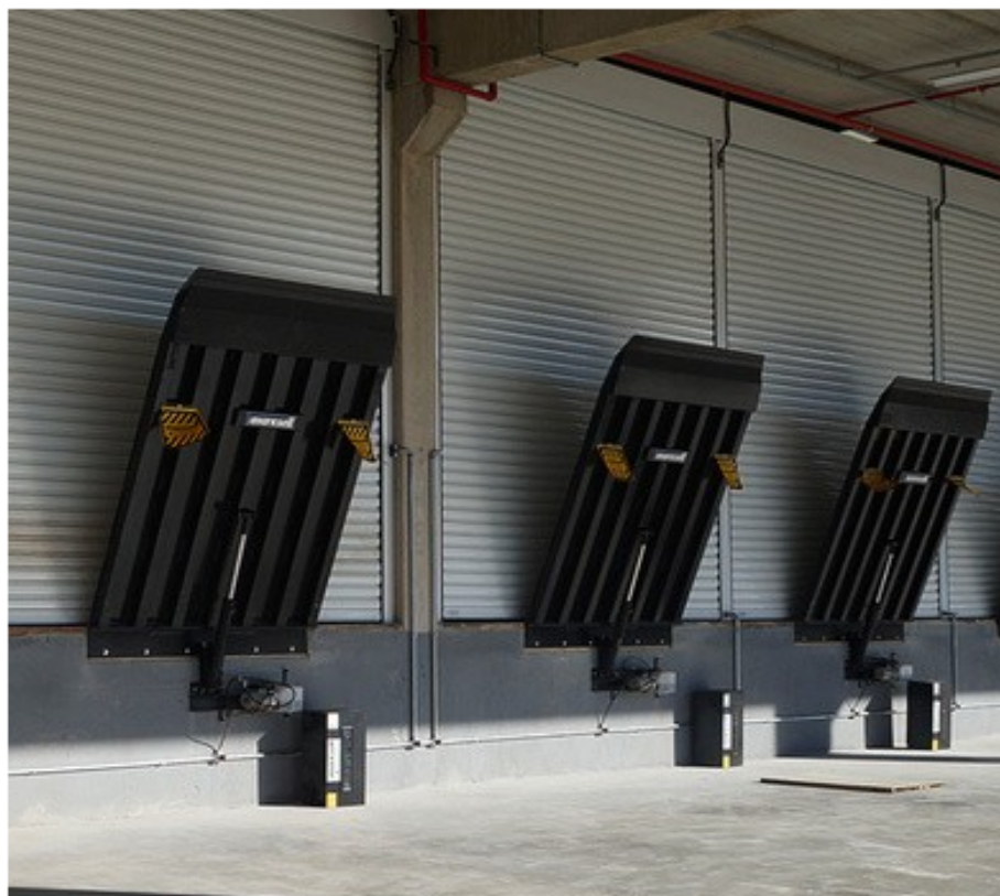
Figura 10 - Niveladora hidráulica 85° externa
