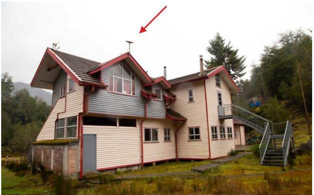
Antena Starlink "Dishy" en el techo de la escuela John F. Kennedy
