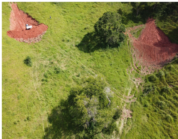
Execução de barraginhas em pastagem
