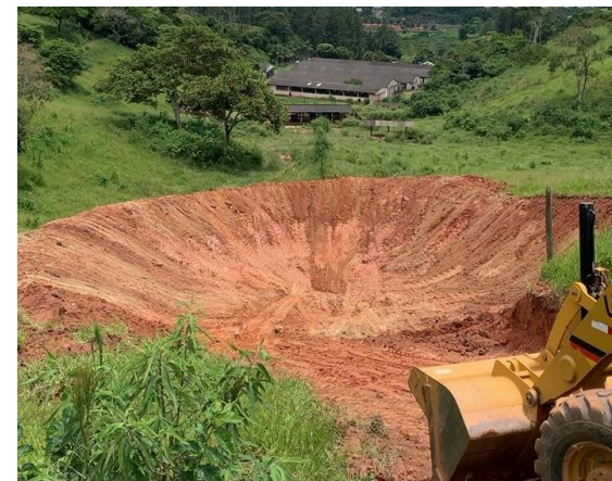
Execução de barraginhas em pastagem
