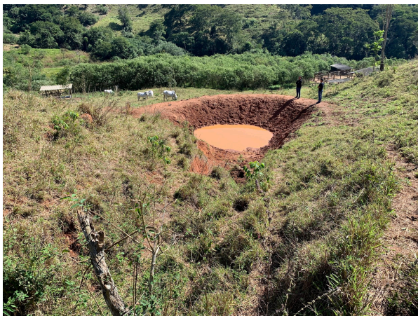
Execução de barraginhas em pastagem
