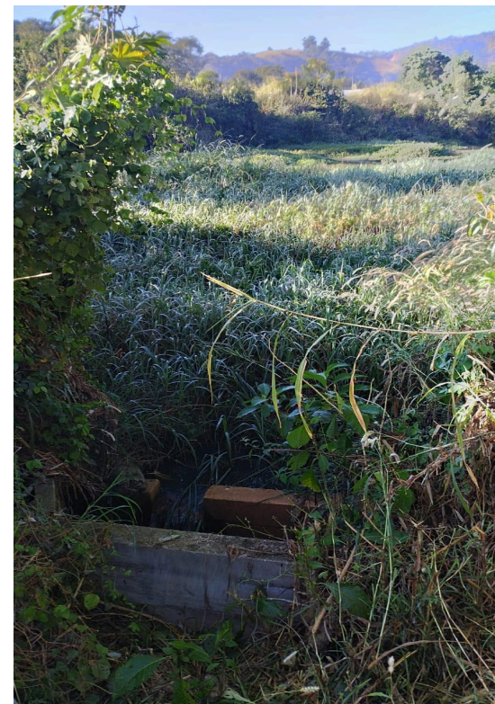
Vertedouro do córrego dos Araújo - Ponto de coleta de amostras de qualidade da Água.
