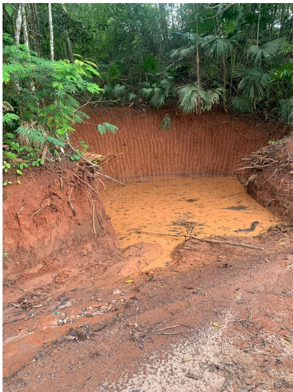
Barraginhas implantadas retendo escoamento e sedimentos (estrada atrás da Escola Estadual Effie Rolfs)
