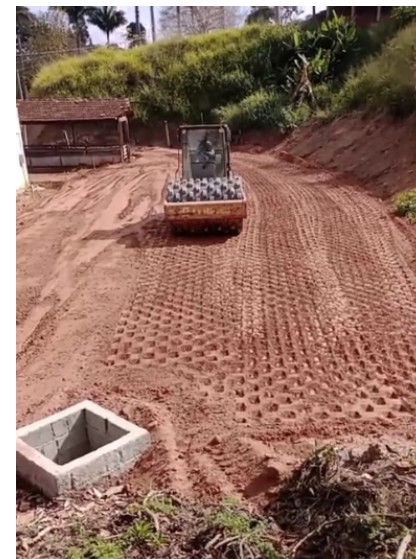
Obras Caprinocultura em andamento - Junho, 2025
