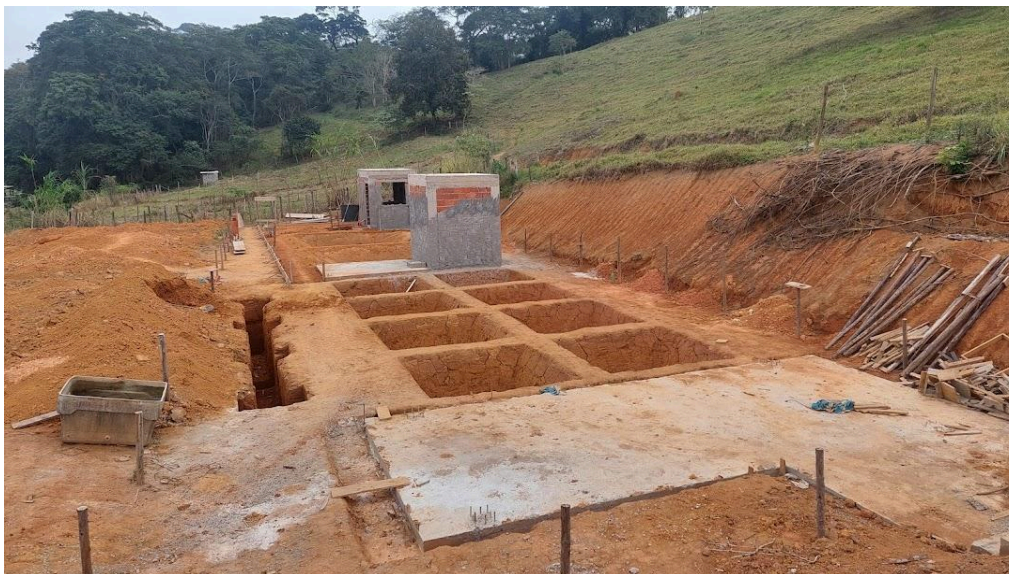
Obras Animal House em andamento - Junho, 2025
