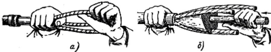
Рис. 6.29. Розведення і вигинання жил кабелю:
