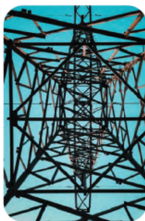
Gambar 4.13.3 Garis Lurus pada Menara Listrik
