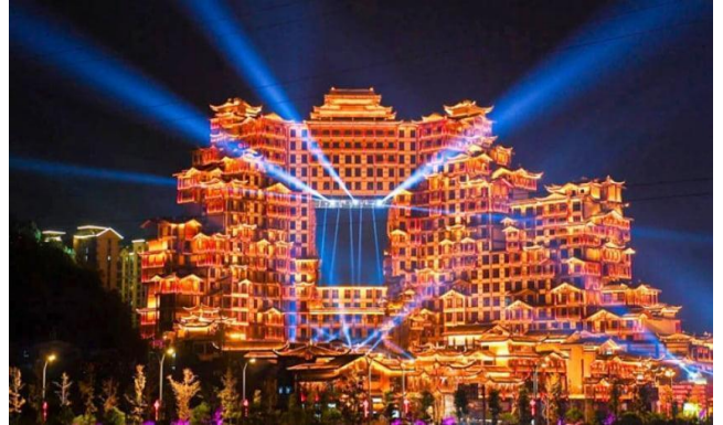
Tòa nhà 72 kỳ lâu
