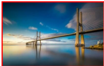
Ponte Vasco da Gama
