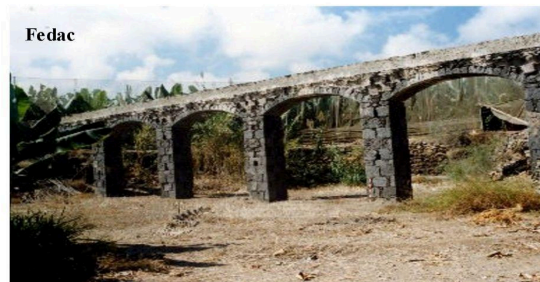
Acueducto El Porrón S. XX lleva el agua desde el estanque de Las Palomas regando la zona hasta el elevador del Cardonal.
