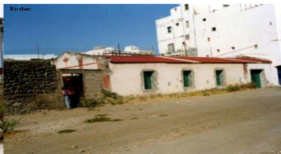
Barranco de Bañaderos pozo S.XX
