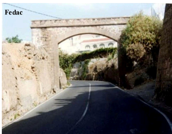
El Cardonal S.XIX Acueducto de la Heredad
