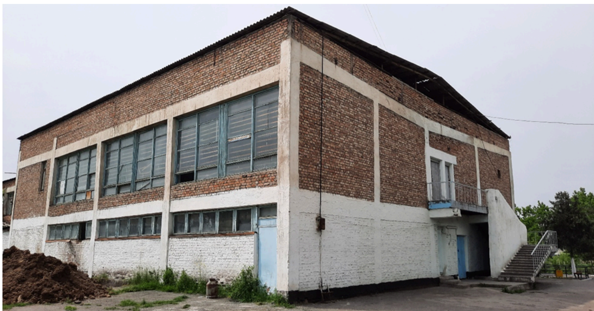
Фото 6. Вид на блок 1-5 (спортзал)
