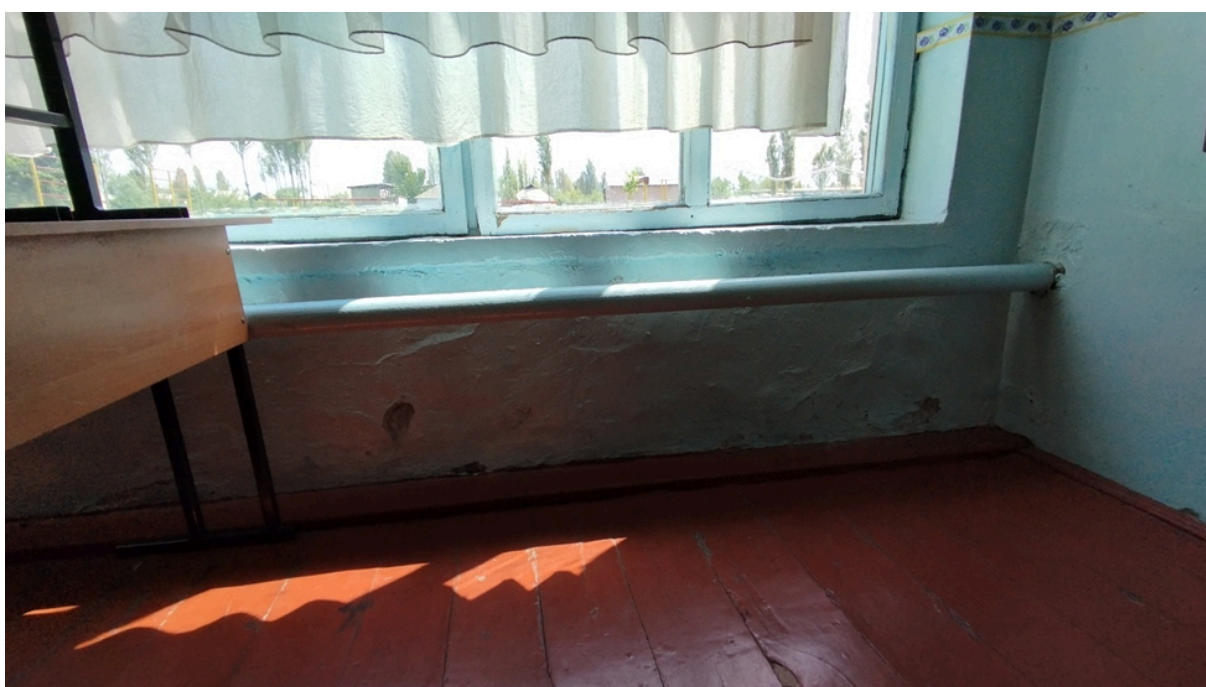
Фото 10. Самодельная система отопления в классах из стальных труб диаметром 150 мм
