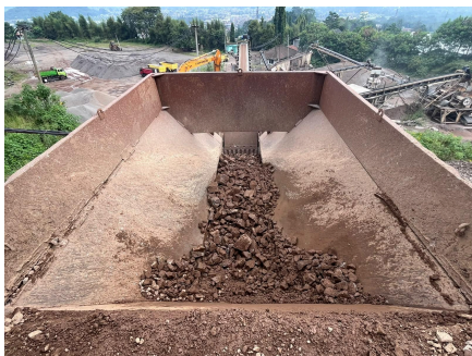
Gambar 6. Material dimasukkan ke hopper
