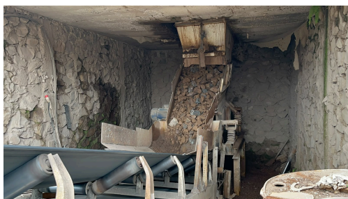
Gambar 7. Pemindahan material untuk diremukkan
