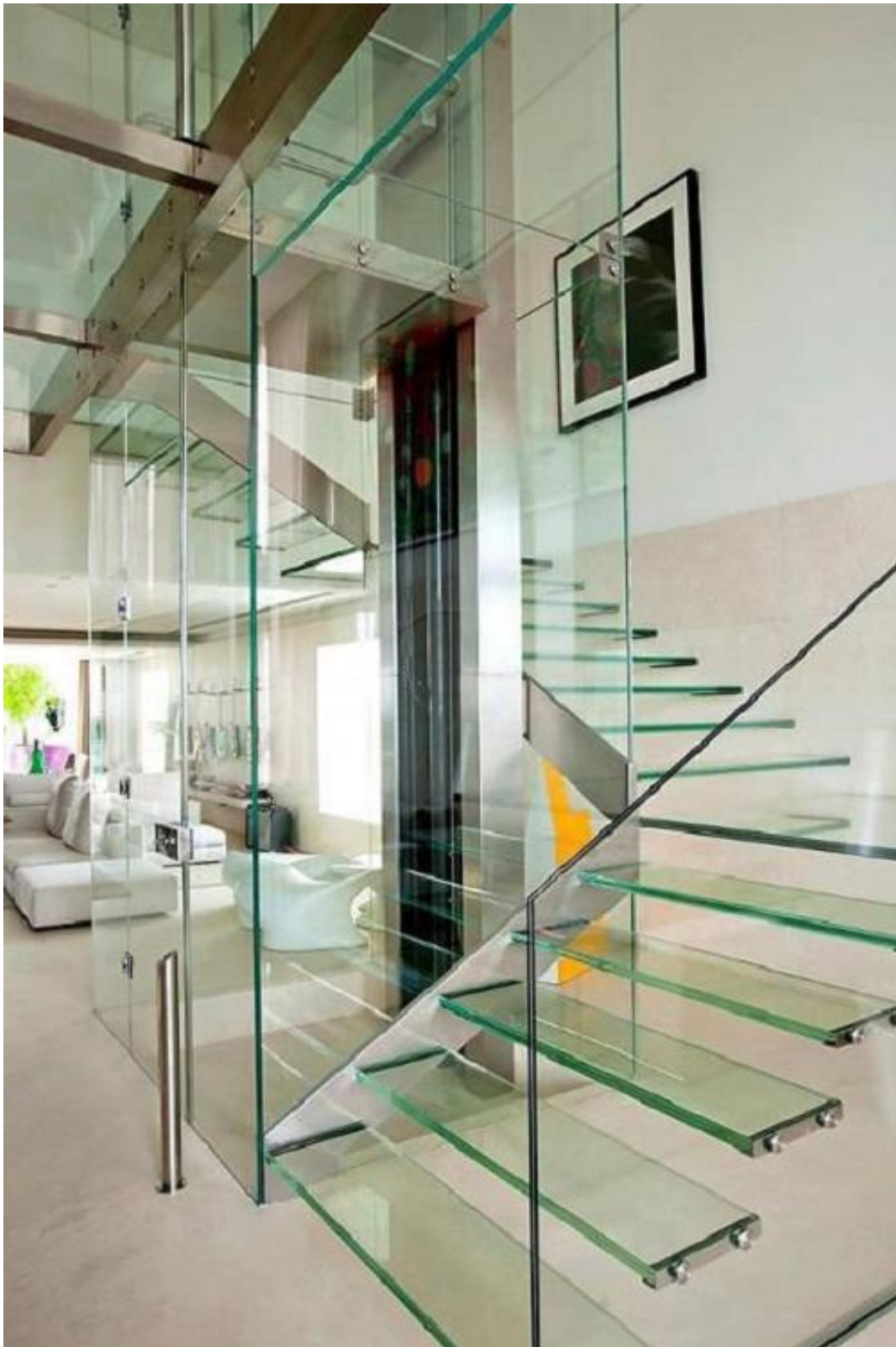
Cầu thang nhà ống 5m sử dụng kính cường lực
