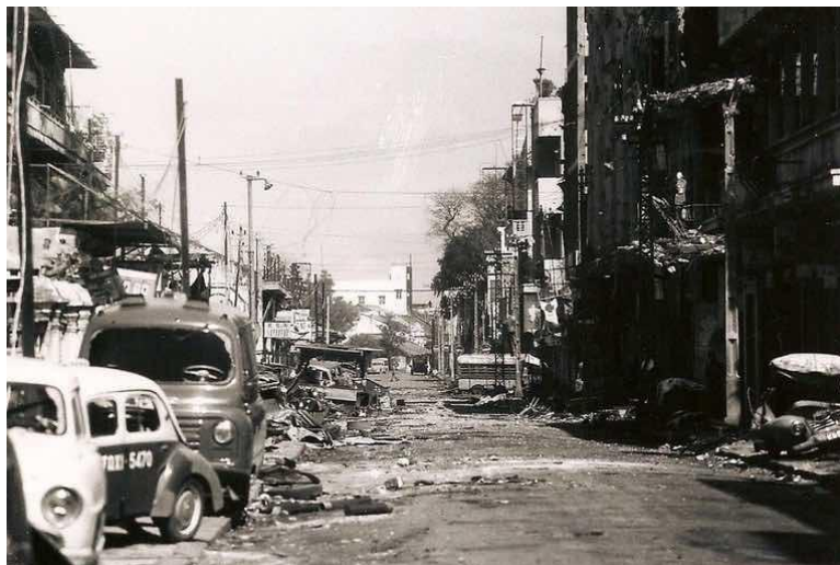
Đường Nguyễn Trãi nhìn từ ngã tư Phùng Hưng – Nguyễn Trãi, quận 5.
