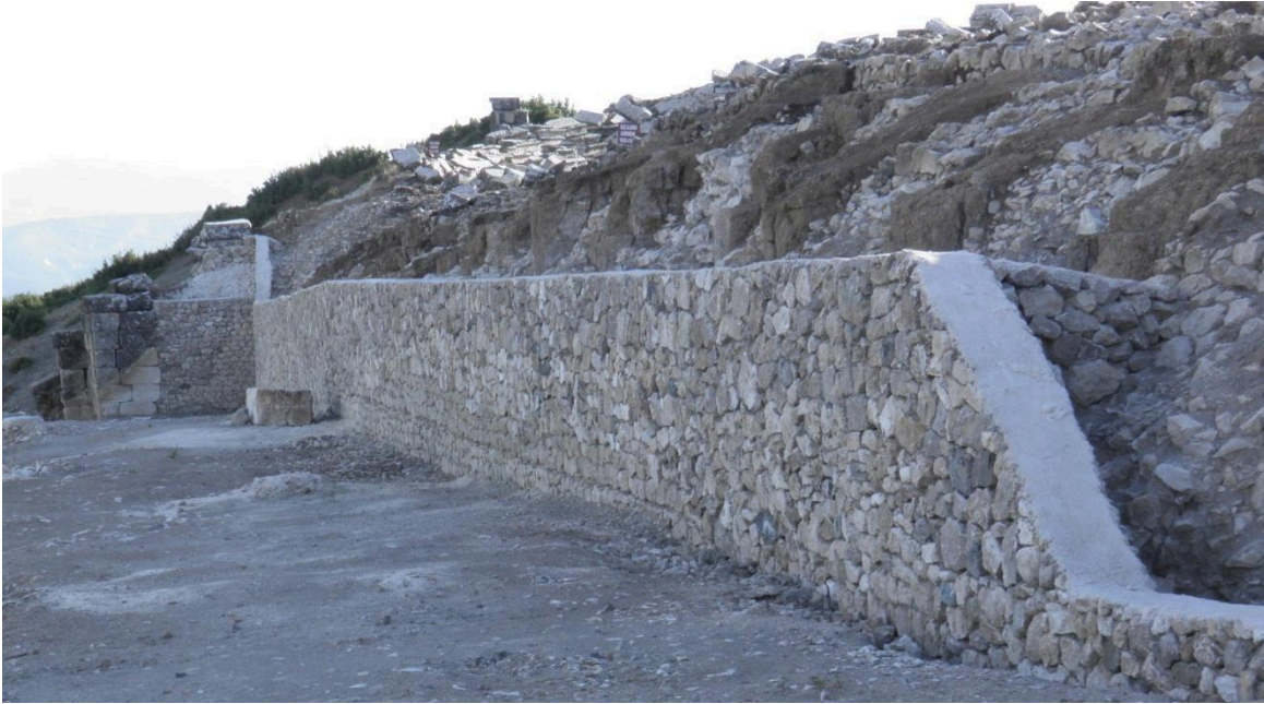
Resim.9: Doğu Oturma Sıraları İstinat Duvarı Onarım Sonrası
