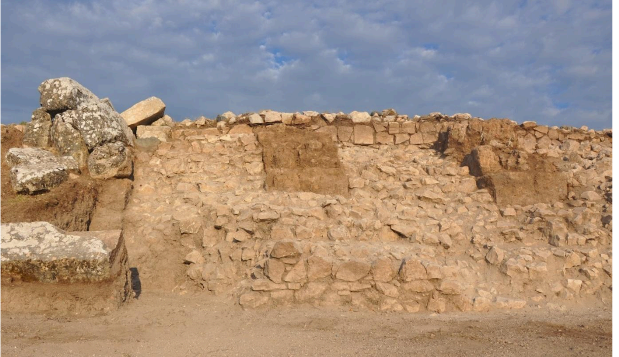
Resim.5: Kemerleri Sağlamlaştırmak İçin Kullanılmış Moloz Dolgu
