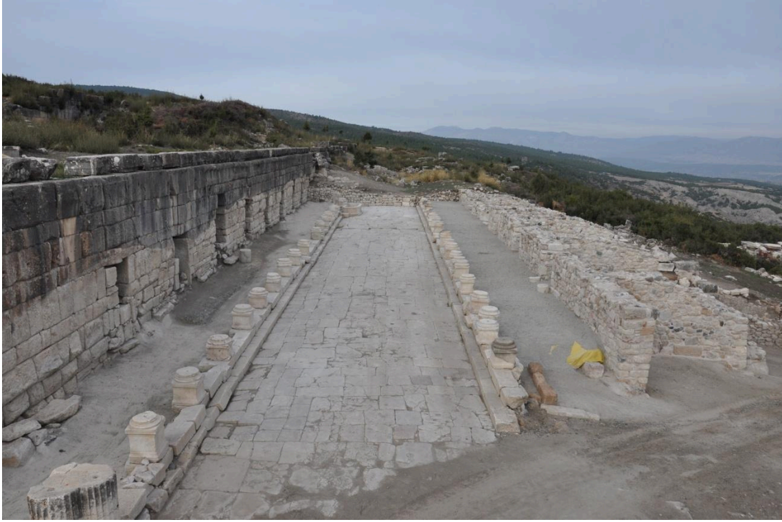
Res.11 Agora, I. Teras Caddesi konservasyon sonrası genel görünüm.
