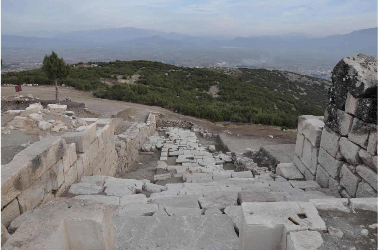
Res.57: KBR'12.Ana Cadde Kazısı kapanış fotoğrafı (Batıdan görünüm).
