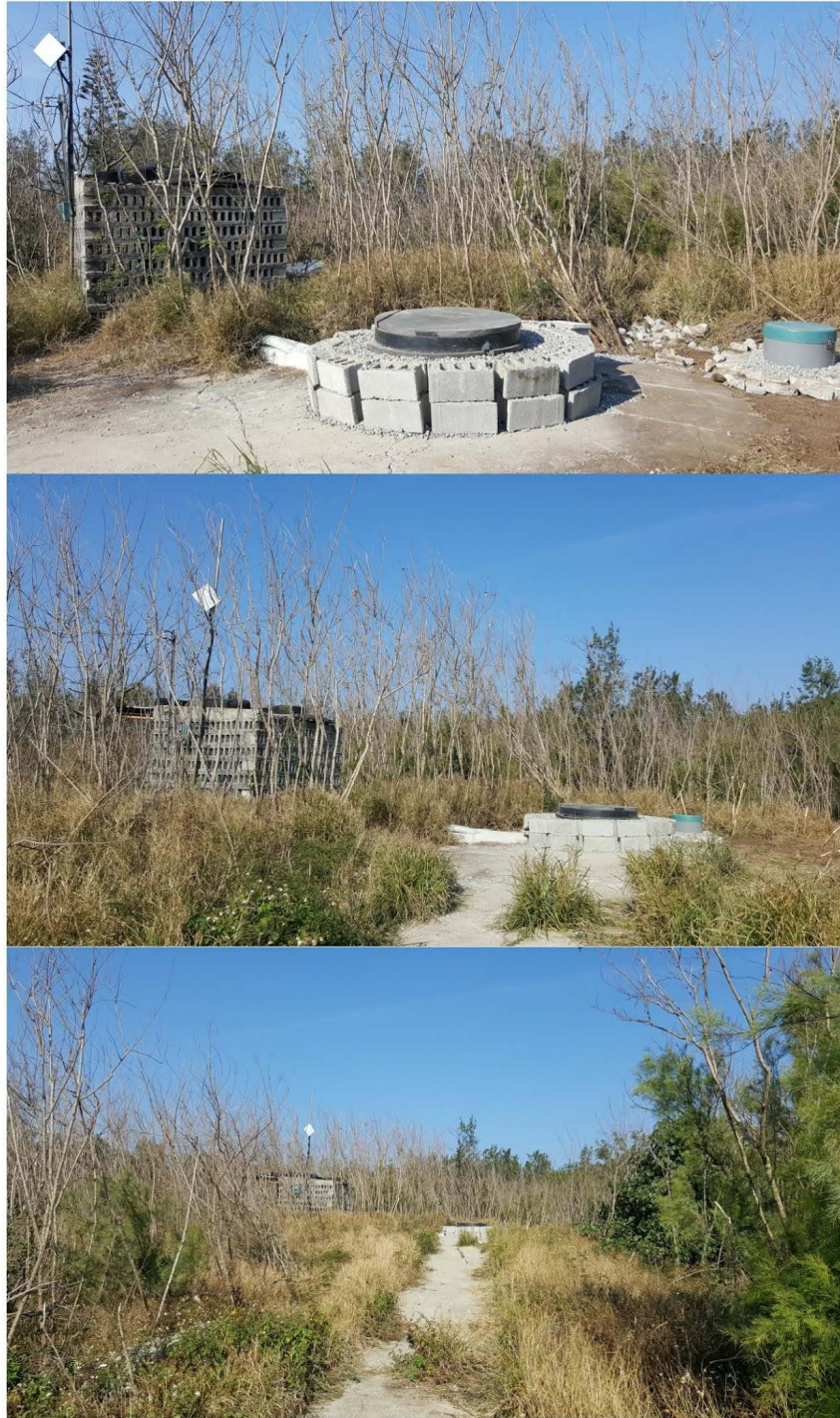
● 澎湖五德營區施工完成，如下圖
