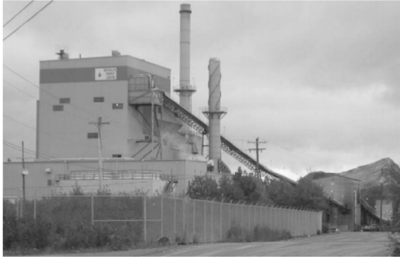
Şekil 0.2: Kanada'da bir biyokütle ateşlemeli köpüren akışkan yatak (Source: Photo by author.)
