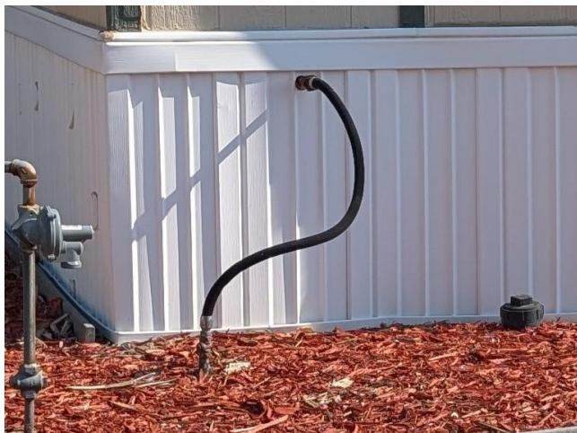
Foto 1: Ejemplo de una línea de conexión de agua en un parque de casas móviles.
