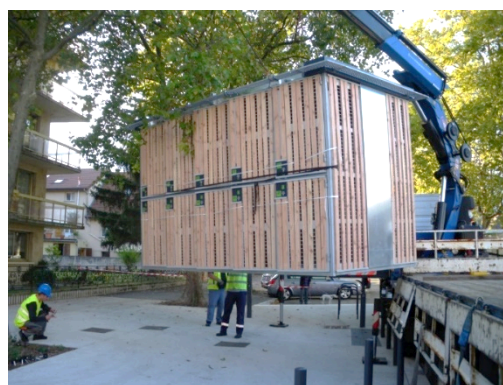
Photo 15 : Installation d'un box à Grenoble
