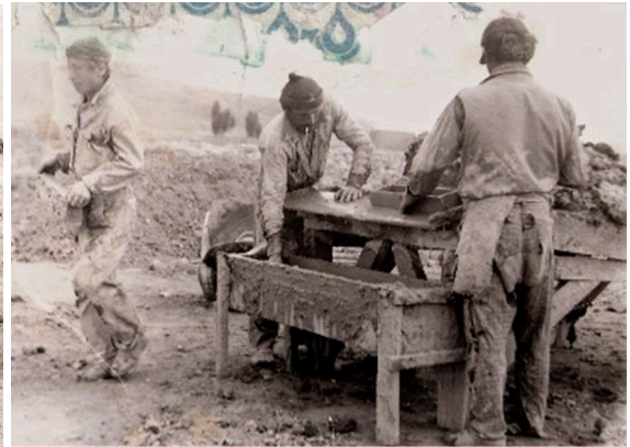
Eski yöntemle tuğla üretimi – Çakal azmağı
