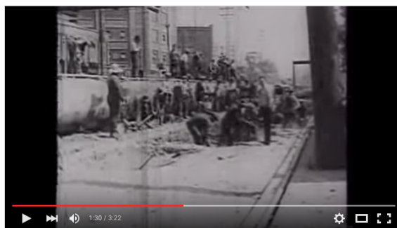
Source de la vidéo : « Aqueducs et égouts à Montréal », Montréal, la cité du progrès (1932), chaîne YouTube des archives de la ville de Montréal.
