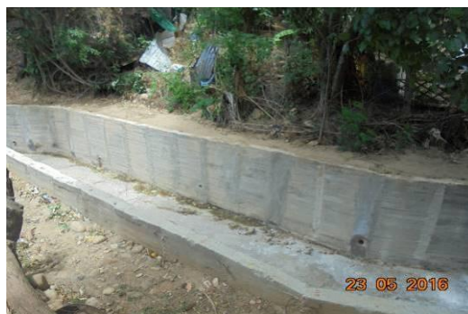
CONSTRUCCIÓN CANAL PRADOS DEL ESTE
